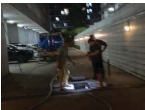
สับตะกอนส่วนเกินและสูบลากไขมันออกจากระบบบำบัดน้ำเสีย
