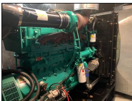
รูปที่ 51 เครื่องกำเนิดไฟฟ้าสำรอง
