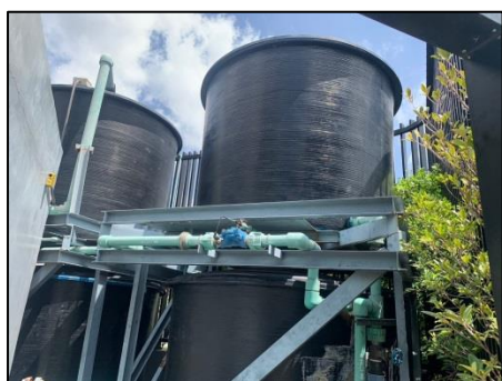
รูปที่ 14 ถังสำรองน้ำคาดฟ้า
