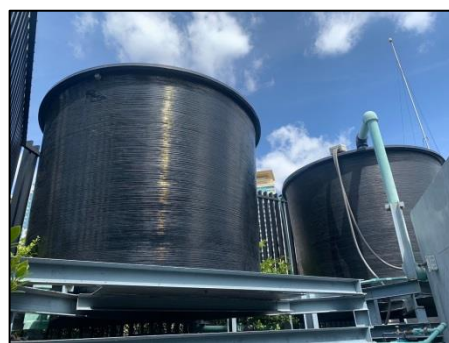
รูปที่ 14 ถังสำรองน้ำคาดฟ้า
