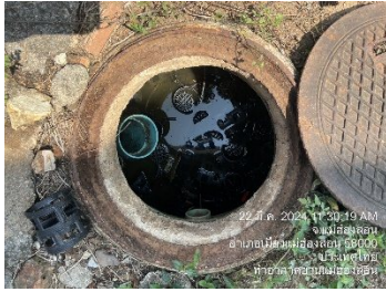
บ่อกักน้ำก่อนเข้าระบบบำบัดน้ำเสียสำเร็จรูปของอาคารผู้โดยสารขาออก จุดที่ 2
