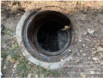
บ่อกักน้ำก่อนเข้าระบบบำบัดน้ำเสียสำเร็จรูปของอาคารผู้โดยสารขาออก จุดที่ 3
