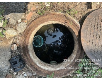
บ่อกักน้ำก่อนเข้าระบบบำบัดน้ำเสียสำเร็จรูปของอาคารหอบังคับการบิน
