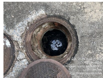
บ่อกักน้ำก่อนเข้าระบบบำบัดน้ำเสียสำเร็จรูปของอาคารผู้โดยสารขาออก จุดที่ 1
