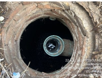
บ่อกักน้ำหลังผ่านระบบบำบัดน้ำเสียสำเร็จรูปของอาคารผู้โดยสารขาออก จุดที่ 1
