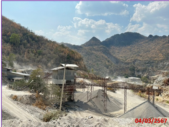
ภาพที่ 2-12 โรงไม้หินของโครงการปิดคลุม 3 ด้าน และการฉีดสเปรย์น้ำบริเวณปากโรงไม้
