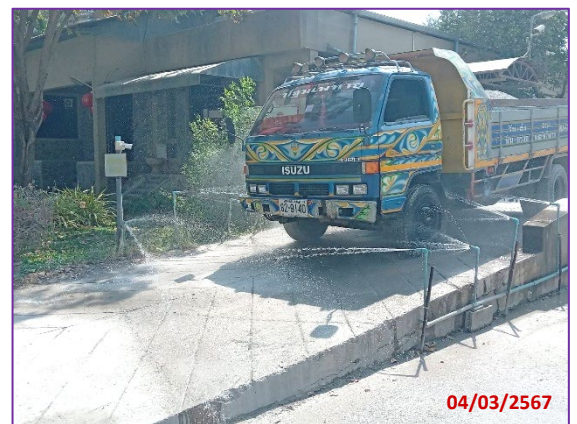
ภาพที่ 2-10 ระบบล้างล้อรถบรรทุกก่อนออกจากพื้นที่โครงการ
