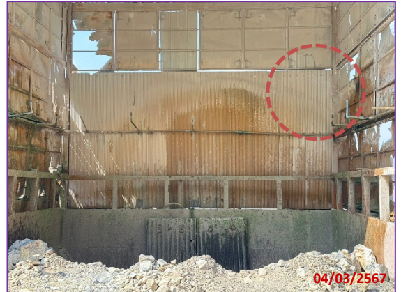
ภาพที่ 2-12 โรงไม้หินของโครงการปิดคลุม 3 ด้าน และการฉีดสเปรย์น้ำบริเวณปากโรงไม้
