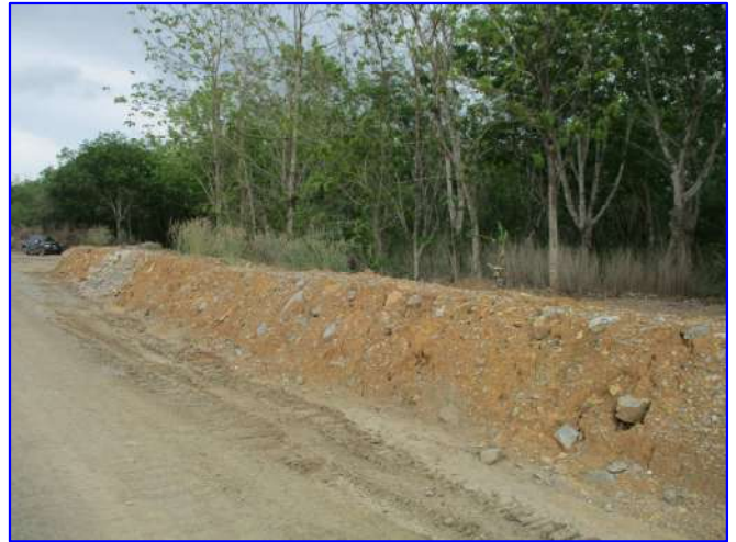
รูปที่ 2.2-2 (ต่อ) การสร้างคั่นทำนบดินในบริเวณพื้นที่โครงการ
