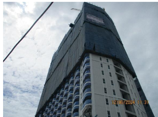
รูปที่ 70 ติดตั้ง Mesh Sheet ตลอดความสูงของอาคาร
