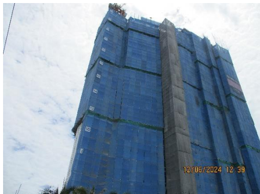
รูปที่ 70 ติดตั้ง Mesh Sheet ตลอดความสูงของอาคาร
