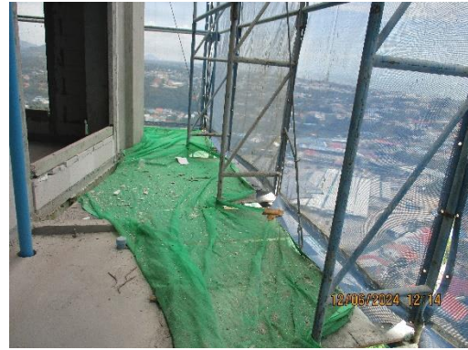
รูปที่ 71 ตะแกรงป้องกันวัสดุตกหล่น
