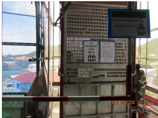
รูปที่ 68 ลิฟต์ขนส่งคนงานและวัสดุก่อสร้าง
