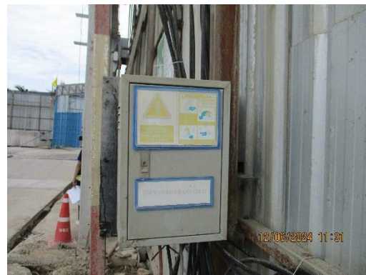
รูปที่ 37 ตู้ควบคุมไฟฟ้า
