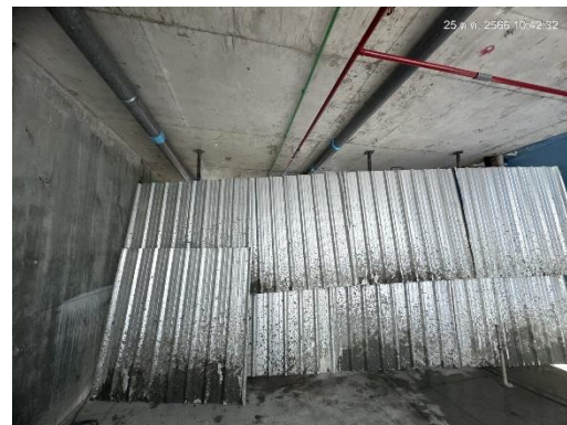
รูปที่ 16 กำแพงกันเสียง โดยใช้ Steel Sheet
