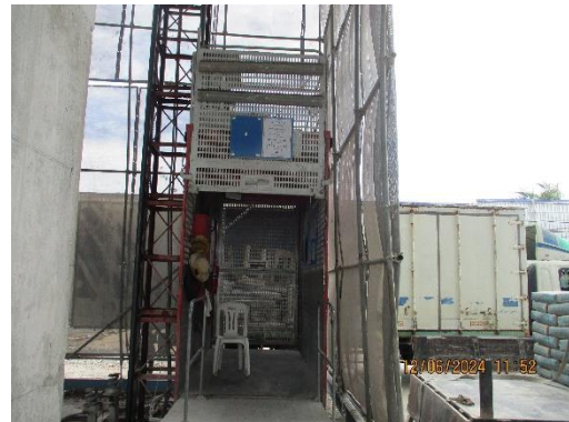
รูปที่ 68 ลิฟต์ขนส่งคนงานและวัสดุก่อสร้าง
