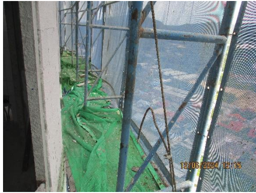
รูปที่ 71 ตะแกรงป้องกันวัสดุตกหล่น
