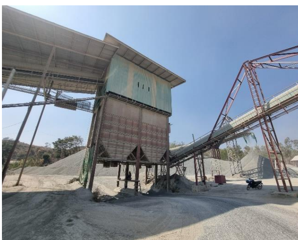
รูปที่ 2-8 โรงโม่หินที่ทำการปิดคลุมแบบระบบปิด
