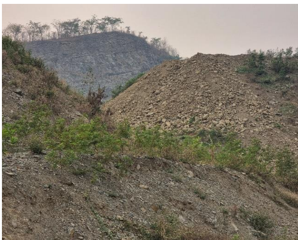
รูปที่ 2-3 การปลูกพืชคลุมดินและไม้ยืนต้นบนคันทำนบดิน
