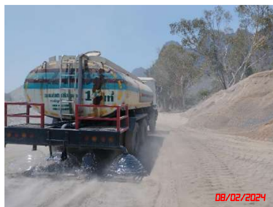
รูปที่ 20 การฉีดพรมน้ำบริเวณเส้นทางขนส่งแร่
