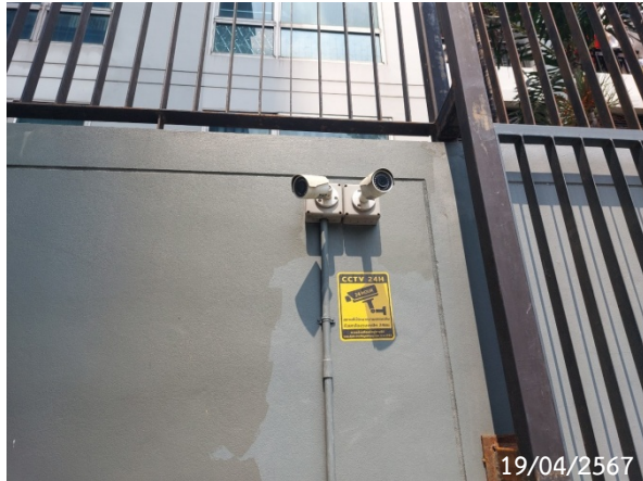
รูปที่ 2-65 ระบบโทรทัศน์วงจรปิด CCTV
