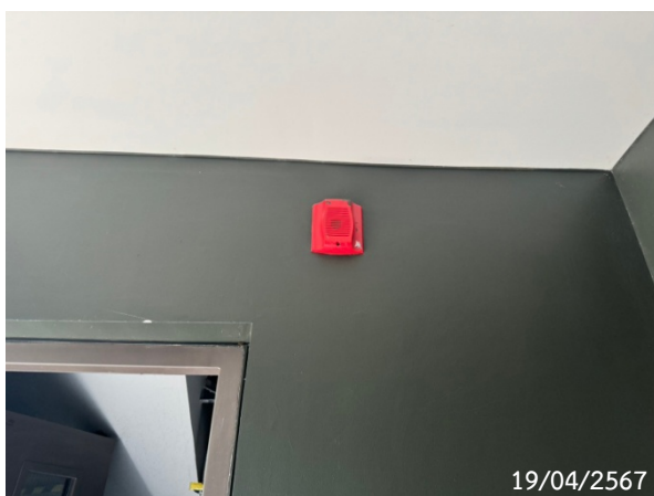
สัญญาณเตือนไฟไหม้
