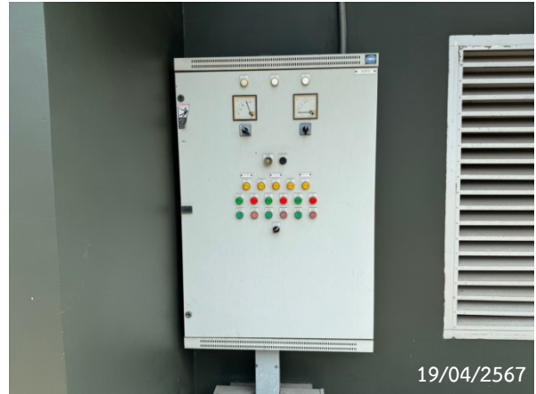
รูปที่ 2-40 ควบคุมเครื่องกำเนิดไฟฟ้า
