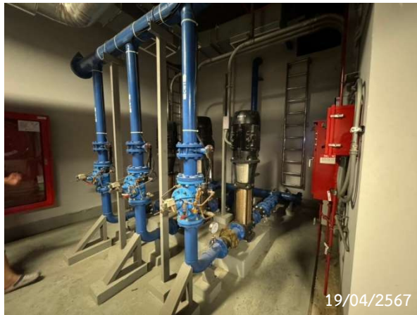
รูปที่ 2-15 ระบบสูบน้ำใช้ในโครงการ
