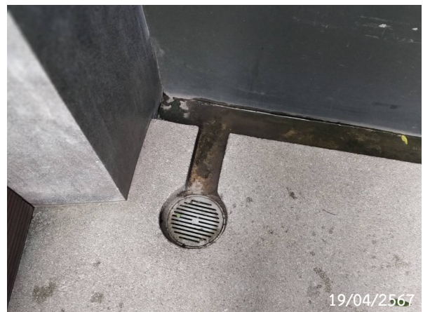
รูปที่ 2-69 ตะแกรงครอบตามรูท่อระบายน้ำทั้ง
