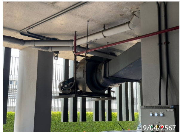
รูปที่ 2-57 พัดลมอัดอากาศ
