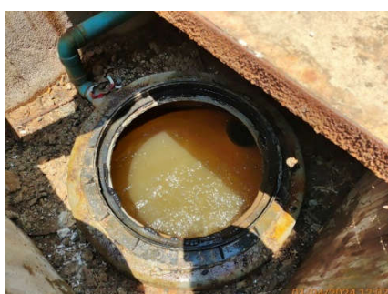
บ่อพักน้ำทั้งหลังผ่านระบบบำบัดน้ำเสีย ของอาคารที่พักผู้โดยสาร ชุดที่ 1
