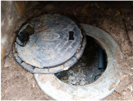
บ่อพักน้ำทิ้งก่อนเข้าสู่ระบบบำบัดน้ำเสีย ของอาคารที่พักผู้โดยสาร ชุดที่ 4
