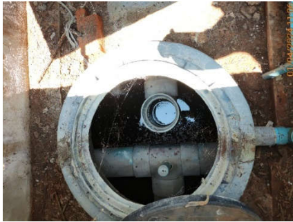
บ่อกักน้ำทิ้งก่อนเข้าสู่ระบบบำบัดน้ำเสีย ของอาคารที่พักผู้โดยสาร ชุดที่ 2
