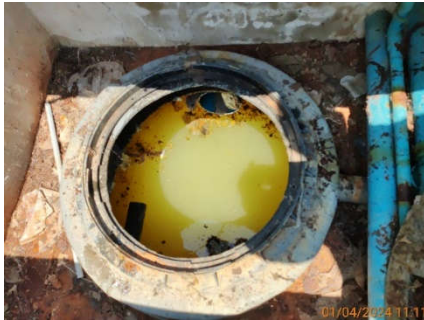
บ่อกักน้ำทิ้งหลังผ่านระบบบำบัดน้ำเสีย ของอาคารที่พักผู้โดยสาร ชุดที่ 2
