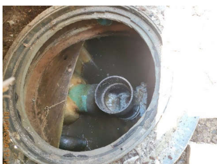
บ่อพักน้ำทั้งก่อนเข้าสู่ระบบบำบัดน้ำเสีย ของอาคารที่พักผู้โดยสาร ชุดที่ 1
