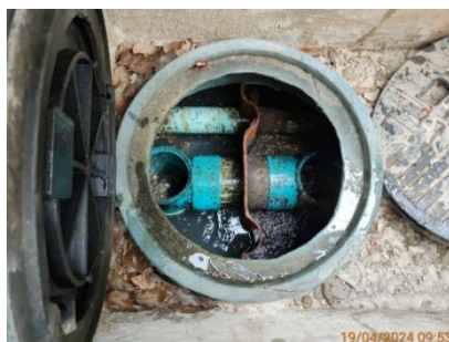
บ่อกักก่อนเข้าสู่ระบบบำบัดน้ำเสียของอาคารที่พักผู้โดยสาร
