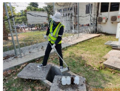
บ่อกักก่อนเข้าสู่ระบบบำบัดน้ำเสียของอาคารที่พักผู้โดยสาร
