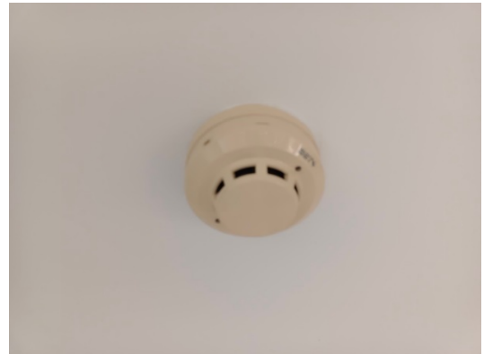
รูปที่ 42 เครื่องจับควัน และชุดดับเพลิงอัตโนมัติ
