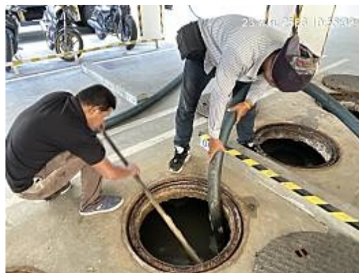
รูปที่ 56 การสูบล้างก่อนจากบ่อเกรอะ
