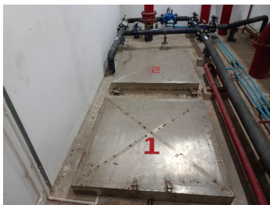
รูปที่ 59 ฝาถังพักน้ำยกสูงจากพื้น
