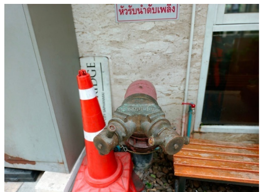
รูปที่ 46 ท่อรับน้ำของโครงการ
