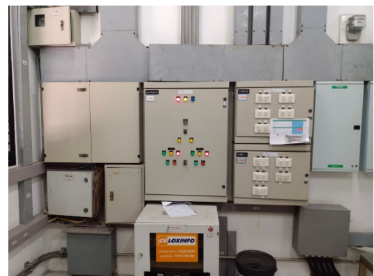
รูปที่ 66 ตู้ควบคุมไฟฟ้าระบบบำบัดน้ำเสีย
