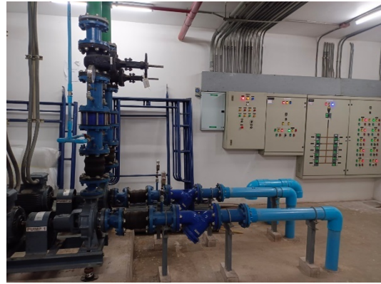
รูปที่ 80 เครื่องสูบน้ำจากชั้นใต้ดินไปยังชั้นคาเฟ่
