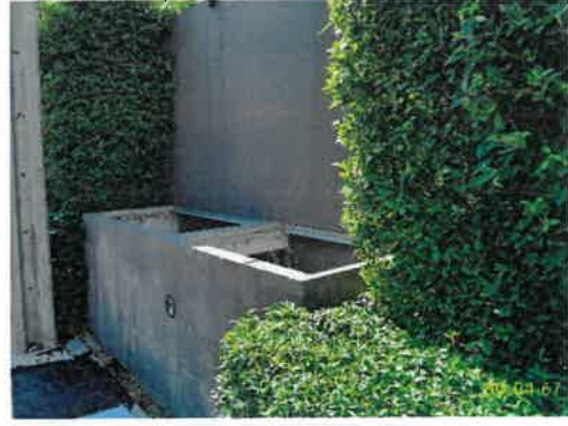
บ่อตรวจคุณภาพน้ำก่อนระบายออกนอกโครงการ ภาพที่ 2.2-10 (ต่อ) การระบายน้ำของโครงการ
