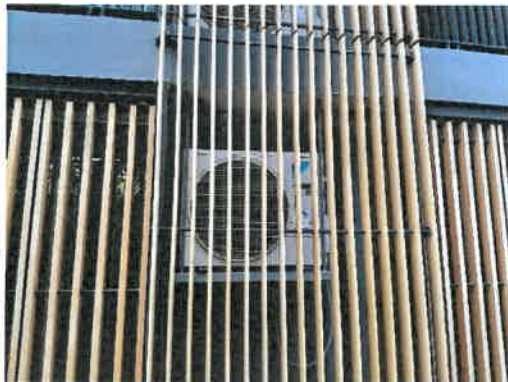
แผงกันระบบระบายอากาศ
