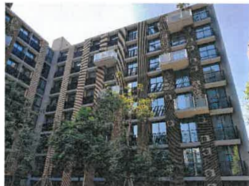
แผงกันระบบระบายอากาศ
