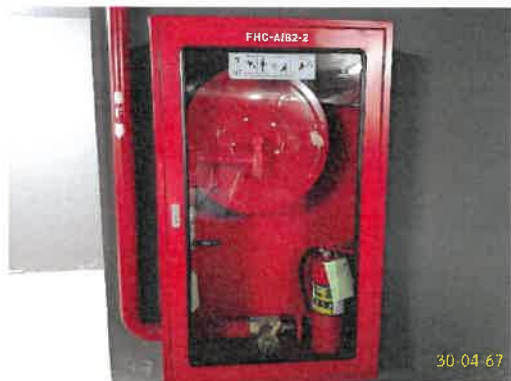
ตู้สายฉีดน้ำดับเพลิงพร้อมอุปกรณ์
