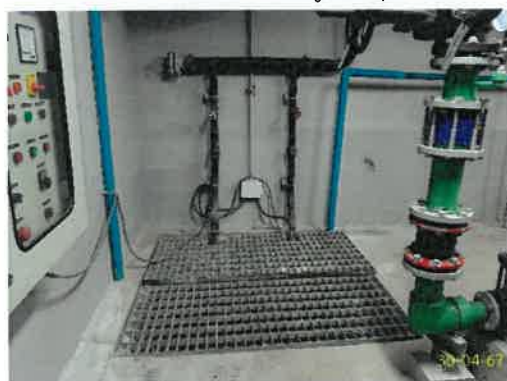
บ่อรับน้ำฝนชั้นใต้ดิน และตู้ควบคุม ตัวที่ 3 ภาพที่ 2.2-10 การระบายน้ำของโครงการ
