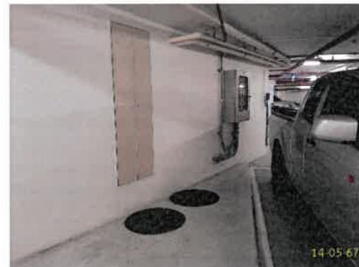
บ่อน้ำ และตู้ควบคุม ชั้นใต้ดิน ระบบระบายน้ำฝนภายในอาคาร ภาพที่ 2.2-5 การระบายน้ำของโครงการ
