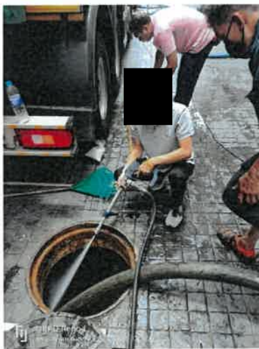
ภาพที่ 2.2-13 สูบตะกอน และตัดไขมัน ระบบบำบัดน้ำเสีย
