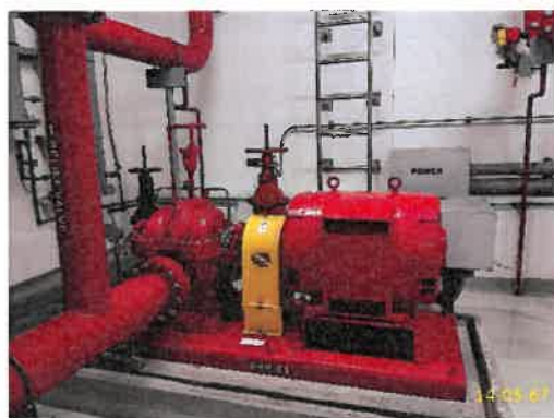
เครื่องสูบน้ำด้วยไฟฟ้าชั้นใต้ดิน
