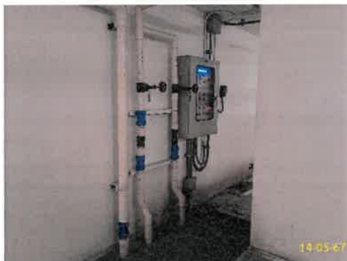
บ่อน้ำ และตู้ควบคุม ชั้นใต้ดิน ระบบระบายน้ำฝนภายในอาคาร ภาพที่ 2.2-5 การระบายน้ำของโครงการ
