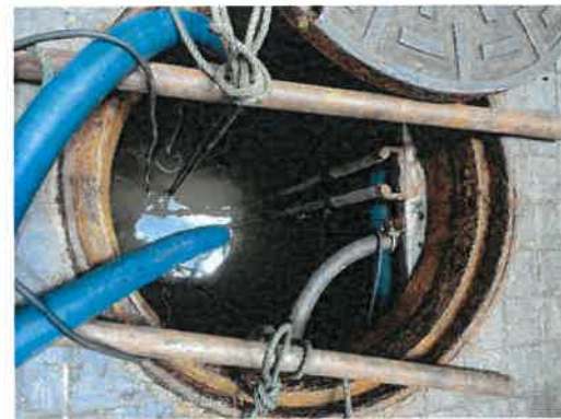
ภาพที่ 2.2-13 สูบตะกอน และตัดไขมัน ระบบบำบัดน้ำเสีย
