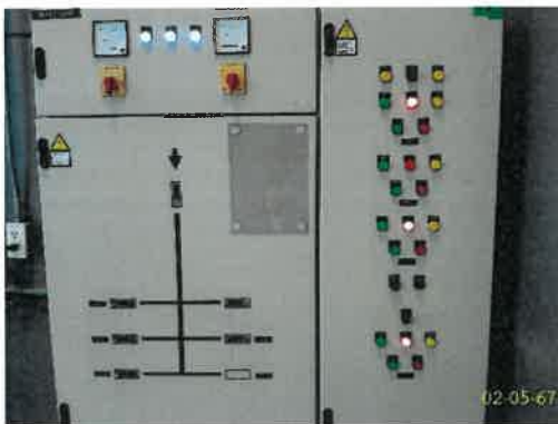
ตู้ควบคุมบ่อน้ำฝน
