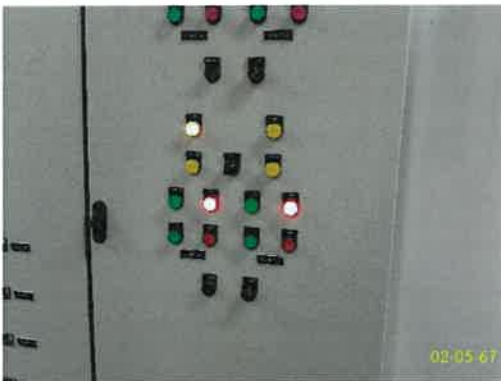
ตู้ควบคุมระบบระบายน้ำฝนชั้นใต้ดิน
