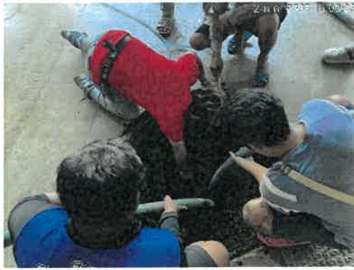
ตักไขมัน และสูบน้ำออกจากระบบบำบัดน้ำเสีย
