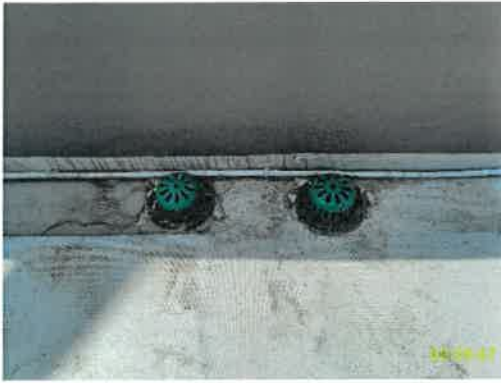
ระบบระบายน้ำฝนจากชั้นหลังคา
