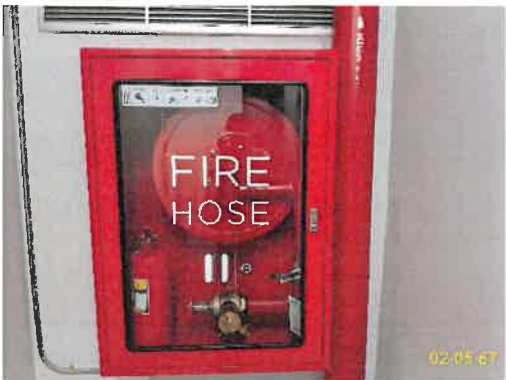
ตู้เก็บสายฉีดน้ำดับเพลิงพร้อมอุปกรณ์
