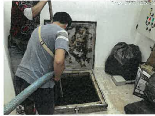
ตักไขมัน และสูบน้ำออกจากระบบบำบัดน้ำเสีย
