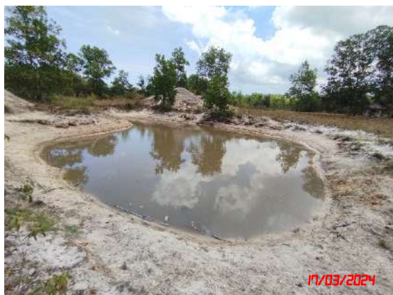
รูปที่ 5 บ่อรับน้ำ (Sump) และบ่อดักตะกอน
