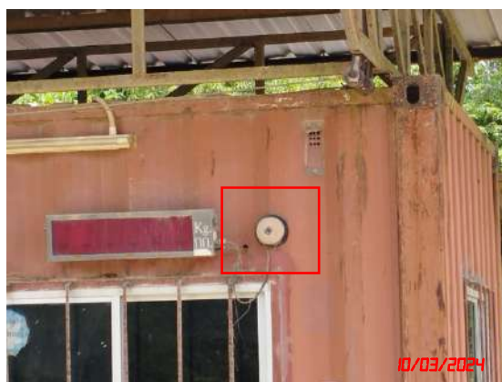
รูปที่ 24 การติดตั้งสัญญาณเตือนก่อนทำการระเบิด
