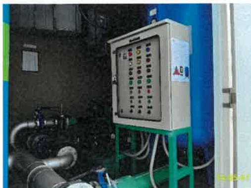
ปั้มน้ำสำรองเพื่อการอุปโภคและบริโภค ชั้นดาดฟ้า
