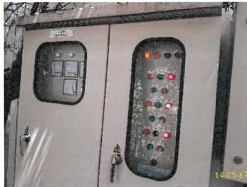
ตู้ควบคุมบ่อสุดท้ายก่อนปล่อยลงสาธารณะ ระบบระบายภายนอกอาคาร (ต่อ) ภาพที่ 1.3.6-1 (ต่อ) ระบบระบายน้ำโครงการ
