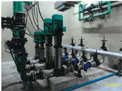
ปั๊มน้ำสำรองเพื่อการอุปโภค-บริโภค ชั้นใต้ดิน อาคาร A
