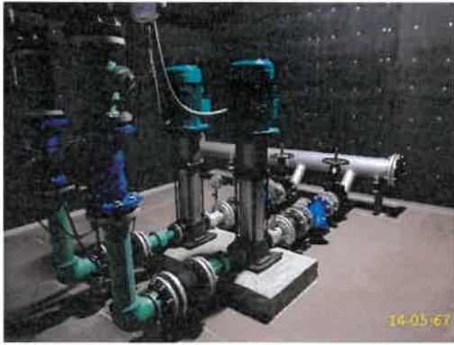
ปั้มน้ำสำรองเพื่อการอุปโภค-บริโภค ชั้น 28M อาคาร A
