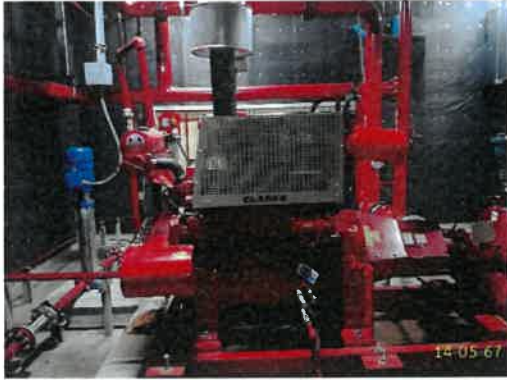
ปั้มน้ำสำรองเพื่อการดับเพลิงชั้น 28M อาคาร A
