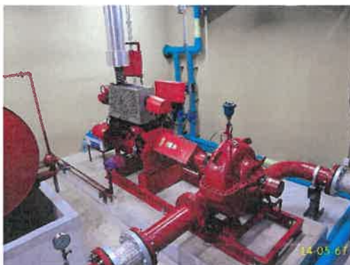
ปั้มน้ำสำรองเพื่อการดับเพลิงชั้นใต้ดิน อาคาร A
