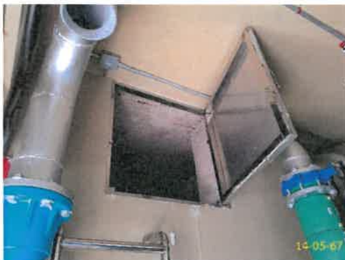
ถังน้ำสำรองเพื่อการอุปโภค-บริโภค ชั้นดาดฟ้า อาคาร A
