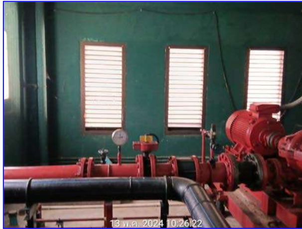
รูปที่ 2.7 น้ำสำรองดับเพลิง
