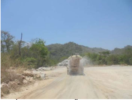
รูปที่ 2-25: การฉีดพรมน้ำเส้นทางขนส่งแร่
