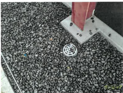
ระบบระบายน้ำฝนจากหลังคาอาคาร ภาพที่ 1.3.6-1 การระบายน้ำของโครงการ
