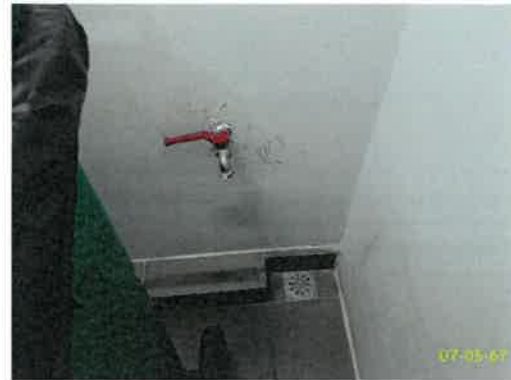
ภาพที่ 2.2-25 ตะแกรงครอบรูท่อระบายน้ำ
