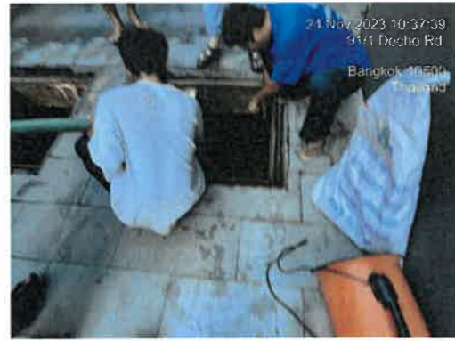
ภาพที่ 2.2-7 สุ่มตะกอนระบบบำบัดน้ำเสีย
