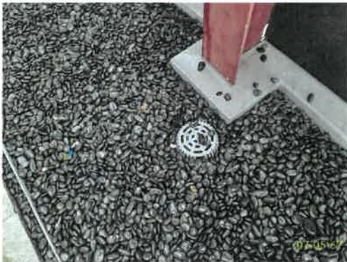
ภาพที่ 2.2-25 ตะแกรงครอบรูท่อระบายน้ำ
