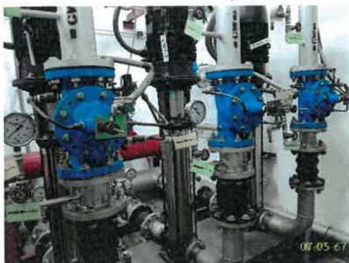
เครื่องสูบน้ำเพื่อการอุปโภค-บริโภคชั้นใต้ดิน
