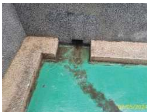
ท่อระบายน้ำฝนชั้นดาดฟ้า
