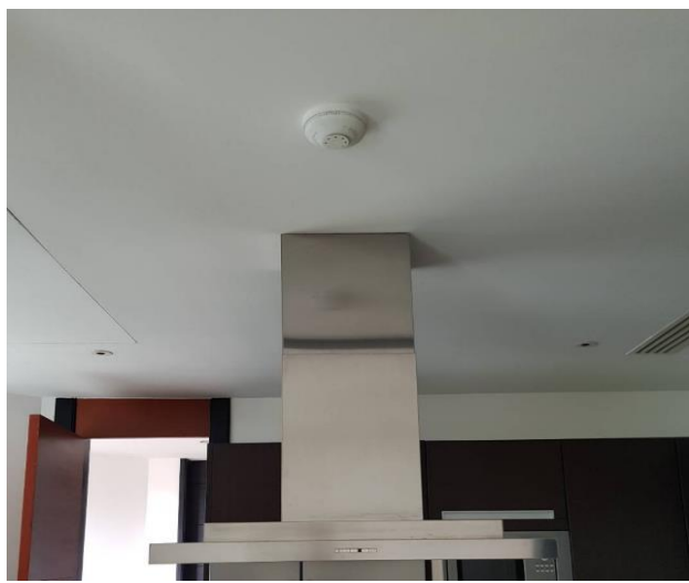
ภาพที่ 32 Heat Detector
