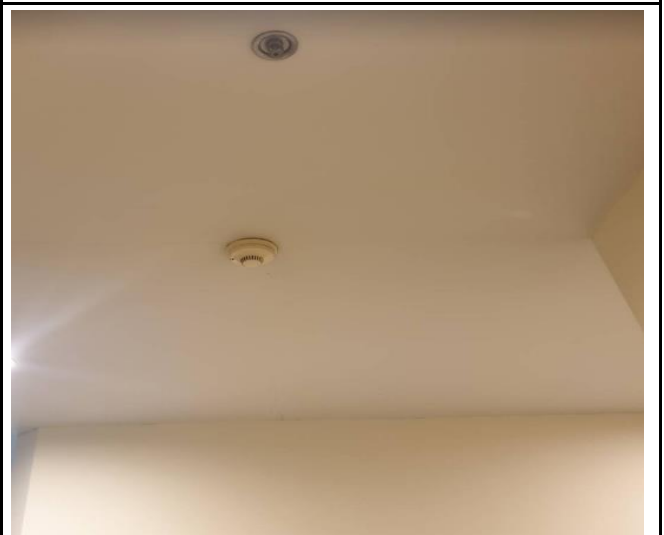
ภาพที่ 31 Smoke Detector
