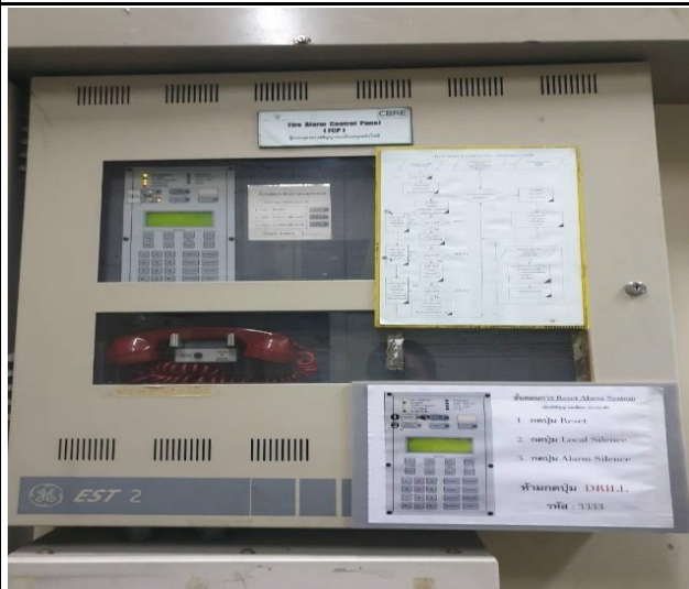
ภาพที่ 30 Fire Alarm Control Panel
