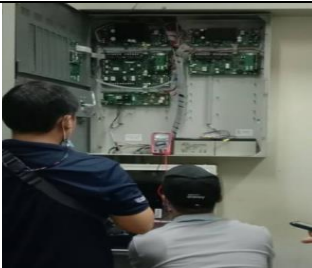
ภาพที่ 36 ตรวจเช็คระบบ Fire Alarm โดยบริษัท ดิยะ มาสเตอร์ ปีละ 3 ครั้ง
