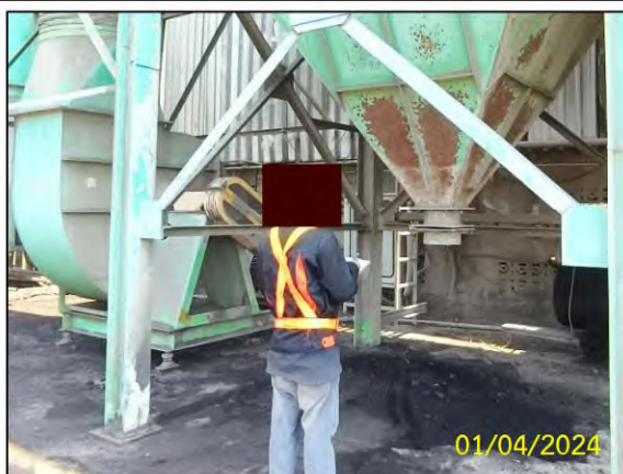
เจ้าหน้าที่ตรวจสอบและบำรุงรักษาระบบกำจัดฝุ่น (Bag Filter)
