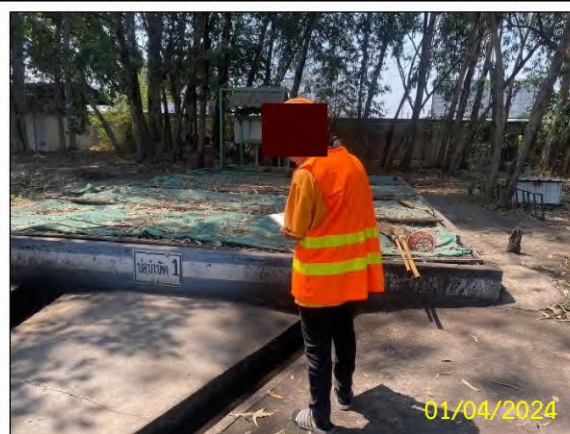
ระบบรวบรวมน้ำบริเวณพื้นที่ขนถ่ายถ่านหินลงสู่บ่อตกตะกอน
