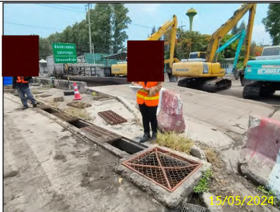
ช) ท่อระบายน้ำบ่อพักน้ำ แบบ คสล. (Manhole) ของโครงการ
