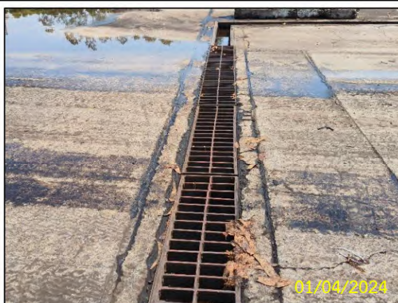
ระบบรวบรวมน้ำบริเวณพื้นที่ขนถ่ายถ่านหินลงสู่บ่อตกตะกอน
