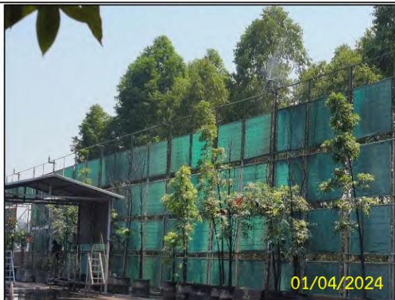
จ) ติดตั้งระบบระบบสเปรย์น้ำ เพื่อป้องกันฝุ่นละออง
