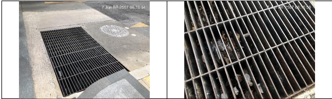
รูปภาพที่ 2-9 ตะแกรงดักมูลฝอยภายในโครงการ
