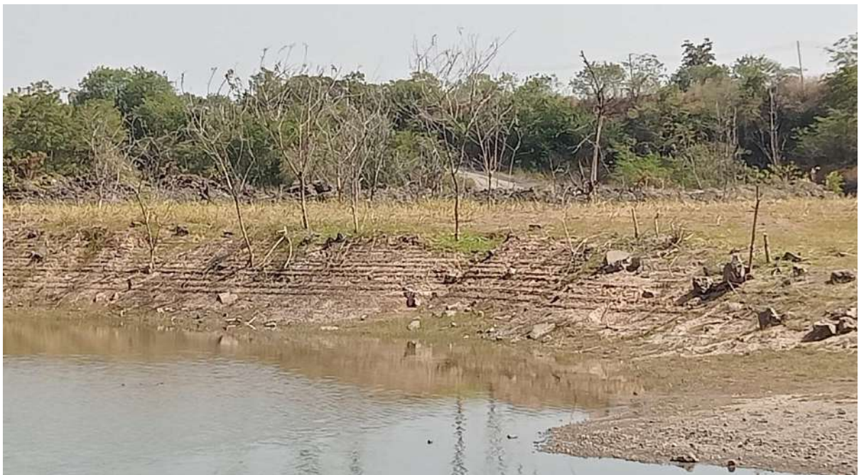
รูปที่ 7 คูแลบ่อที่เคยขุดไว้ให้อยู่ในสภาพที่ดี มีการขุดลอกตะกอนออกจากบ่อเป็นประจำ และมีการขุดคูระบายน้ำรอบพื้นที่เก็บกองดิน
