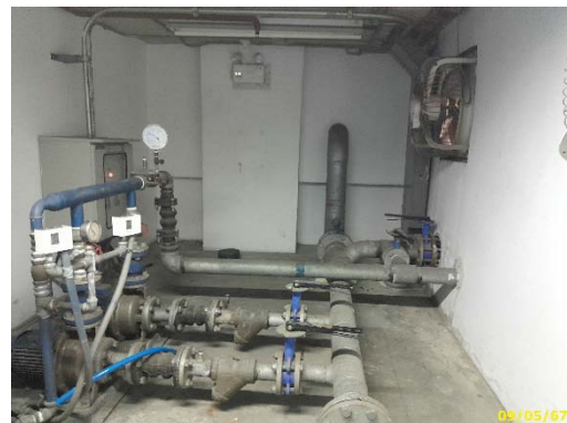
Booster pump และถังสำรองน้ำชั้นดาดฟ้า
