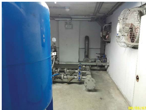
Booster pump และถังสำรองน้ำชั้นดาดฟ้า
