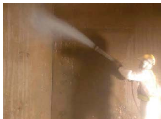
การล้างถังสำรองน้ำใช้ ภาพที่ 2.2-5 ระบบน้ำใช้
