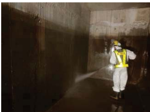
การล้างถังสำรองน้ำใช้ ภาพที่ 2.2-5 ระบบน้ำใช้
