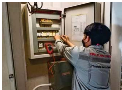
ตรวจสอบระบบป้องกัน/ระบบอัคคีภัยและเตือนอัคคีภัย
