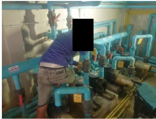
การทำความสะอาดเครื่องกรองสระว่ายน้ำ
