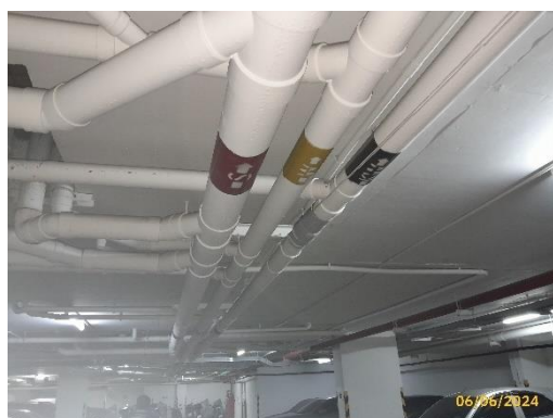
ระบบระบายน้ำเสียและสิ่งปฏิกูล ภาพที่ 1.3.4-1 ระบบบำบัดน้ำเสียและสิ่งปฏิกูล
