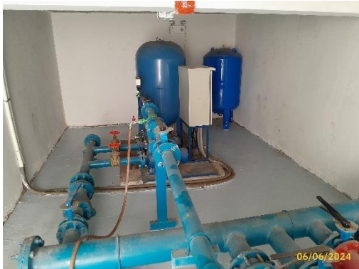
ปั้มน้ำเสริมแรงดันอาคาร D
