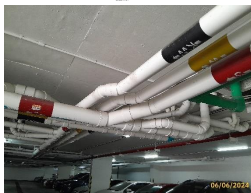
ระบบระบายน้ำเสียและสิ่งปฏิกูล ภาพที่ 1.3.4-1 ระบบบำบัดน้ำเสียและสิ่งปฏิกูล
