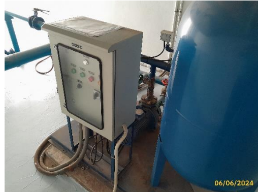
ปั้มน้ำเสริมแรงดันอาคาร D
