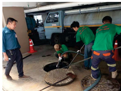
การทำความสะอาดและดูดตะกอน
