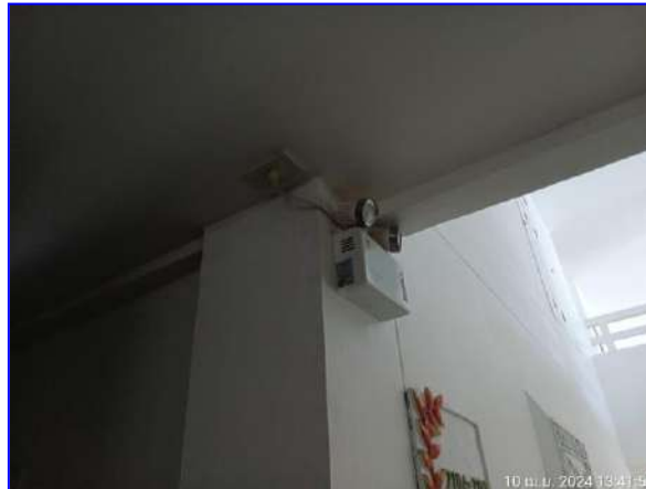
รูปที่ 2.35 เครื่องสำรองไฟฉุกเฉิน
