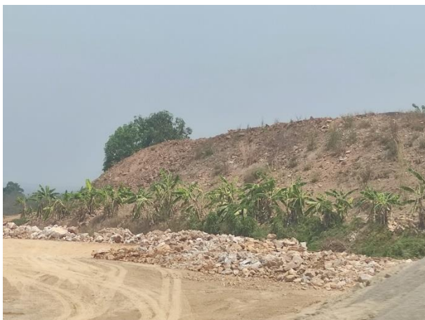
รูปที่ 2-10 (ต่อ) การปลูกพืชคลุมดินบริเวณผนังคั่นทำนบดิน และปลูกต้นไม้บนคั่นทำนบดิน
