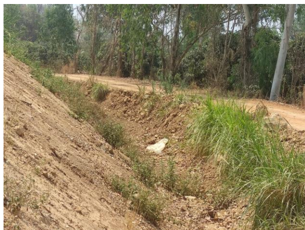
รูปที่ 2-8 (ต่อ) คันทำนบดินโดยรอบจุดกองเปลือกดิน
