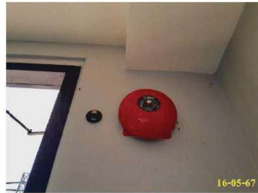
กริ่งสัญญาณเตือนอัคคีภัย (Fire Alarm Bell)
