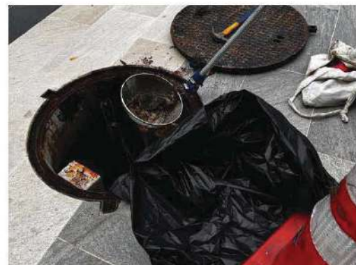
เจ้าหน้าที่ตัดกากไขมันระบบบำบัดน้ำเสีย
