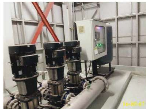
ถังเก็บน้ำชั้นดาดฟ้า พร้อมเครื่องปั๊มน้ำชั้นดาดฟ้า
