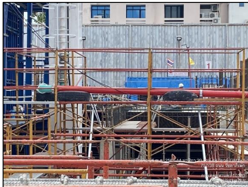
ภาพที่ 73 วัสดุป้องกันและดูดซับการสั่นสะเทือน
