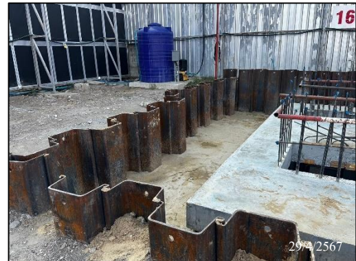
ภาพที่ 22 Sheet Pile และระบบค้ำยัน
