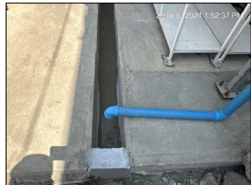
ภาพที่ 23 รางระบายน้ำคอนกรีต
