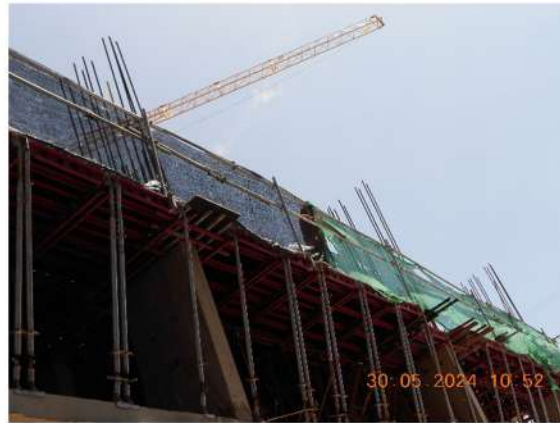
รูปที่ 2-7 ผ้าใบก่อสร้าง (Mesh Sheet)
