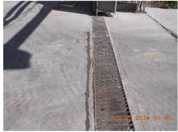
รูปที่ 2-2 ท่อและรางระบายน้ำของโครงการ
