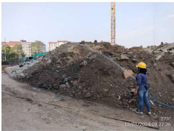
รูปที่ 2-8 ฉีดพรมน้ำบริเวณพื้นที่ก่อสร้าง
