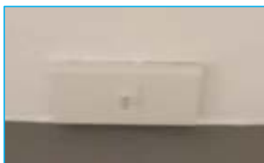
ภาพที่ 2-4(4.5-8) ระบบสัญญาณแจ้งเหตุเพลิงไหม้หน้าห้องพัก LED Indicating Lamp
