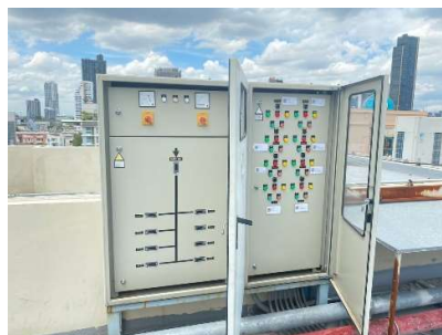
ตู้ควบคุมระบบระบายอากาศ
