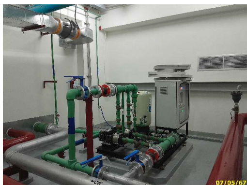
เครื่องปั้มน้ำชั้นห้องเครื่องลิฟต์
