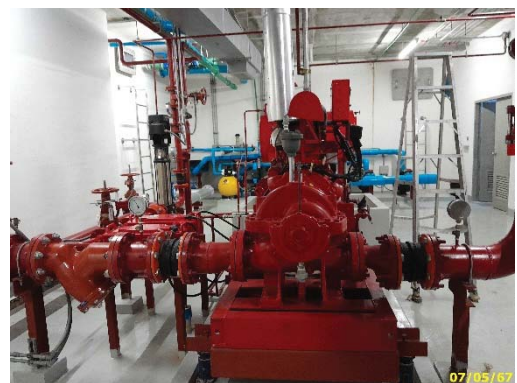
เครื่องปั้มน้ำดับเพลิงขึ้นใต้ดิน
