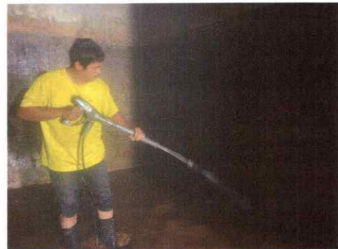
การทำทำความสะอาดผนังด้วยปืนฉีดน้ำแรงดันสูง
