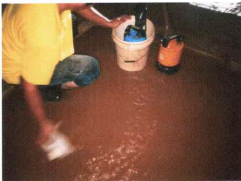
สภาพภายในถังระหว่างการสูบน้ำและตะกอนออก
