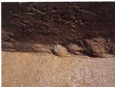
ถังใต้ดินมีการหลุดร่อนของพื้นปูนบางส่วน
