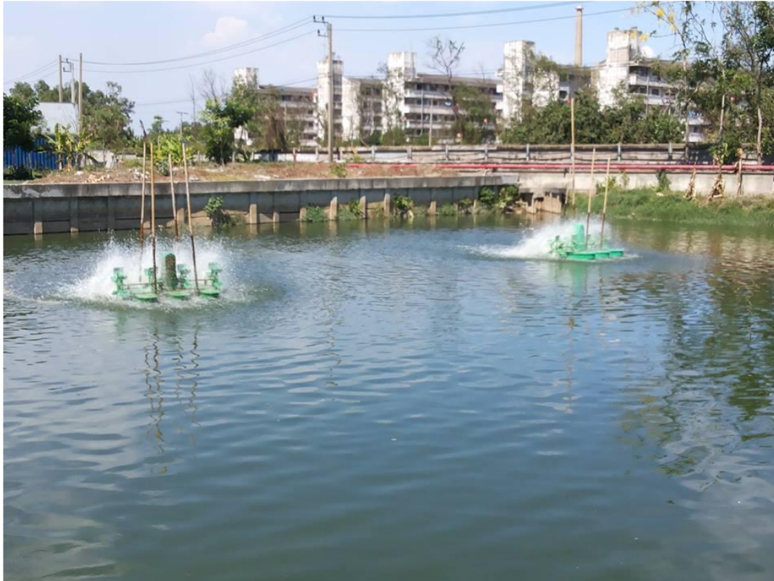
ภาพที่ 3-16 บ่อเติมอากาศ (Aeration Pond)
