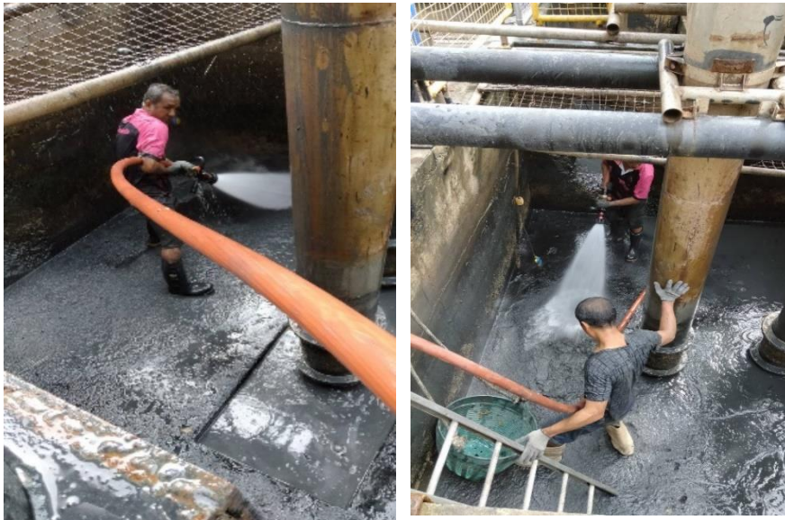
ภาพที่ 3-10 การล้างบ่อตามแผนงาน โดยการฉีดน้ำโคลนด้าน นอกที่ไม่เคยล้างทำความสะอาดออกหมด
