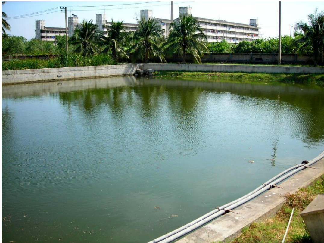
ภาพที่ 3-17 บ่อดกตะกอน (Sedimentation Pond)
