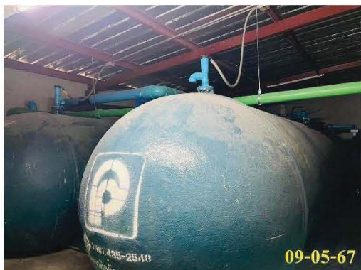
ถังเก็บน้ำชั้นดาดฟ้า พร้อมเครื่องปั้มน้ำ อาคาร B
