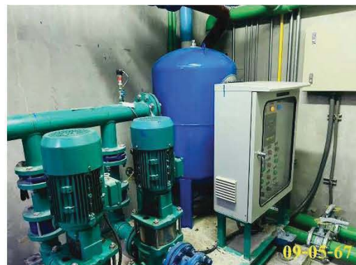
ถังเก็บน้ำชั้นดาดฟ้า พร้อมเครื่องปั้มน้ำ อาคาร B
