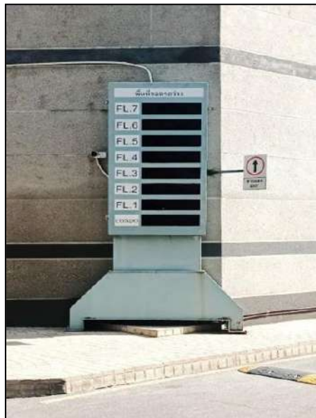
ภาพที่ 2-10 ระบบการตรวจนับช่องจอดรถในส่วนของ Plaza
