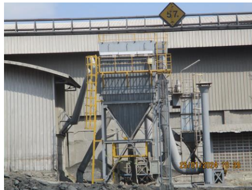
รูปที่ 2 ระบบดักฝุ่นแบบถุงกรอง (BF)
