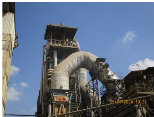
รูปที่ 6 AQC Boiler
