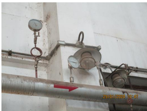
รูปที่ 43 เครื่องวัดแรงดันไอน้ำแบบเกจวัด
