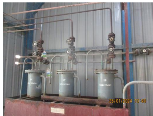
รูปที่ 44 ระบบท่อตรวจวัดคุณภาพน้ำ
