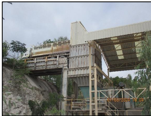
ภาพที่ 2.44 หลังคาปิดคลุมบริเวณ Hopper
