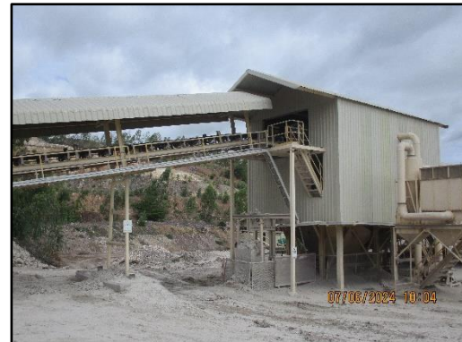
ภาพที่ 2.13 อาคารและสายพานระบบปิดของระบบย่อยถ่านหิน
