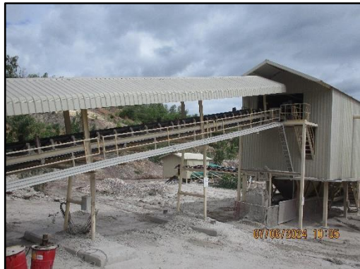
ภาพที่ 2.13 อาคารและสายพานระบบปิดของระบบย่อยถ่านหิน
