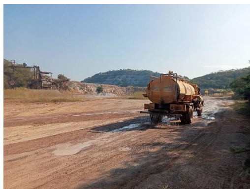
รูปที่ 6 การฉีดพรมน้ำเส้นทางขนส่ง
