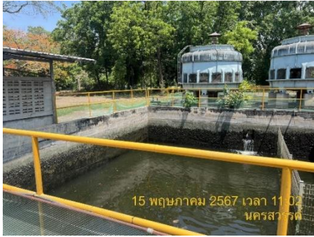
รูปที่ 25 บ่อพักน้ำทิ้งจากระบบหล่อเย็น
