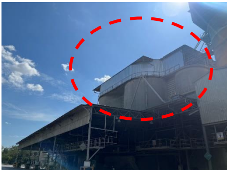
รูปที่ 58 ติดตั้งแผ่นเมทัลชีทบนไซโลปูนผง
