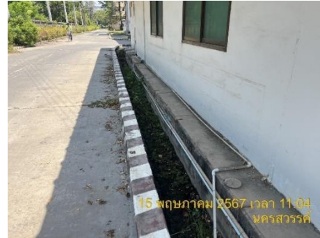
รูปที่ 41 รางระบายน้ำฝนหลักของโครงการ
