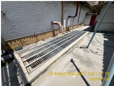
รูปที่ 25 บ่อพักน้ำทิ้งจากระบบหล่อเย็น
