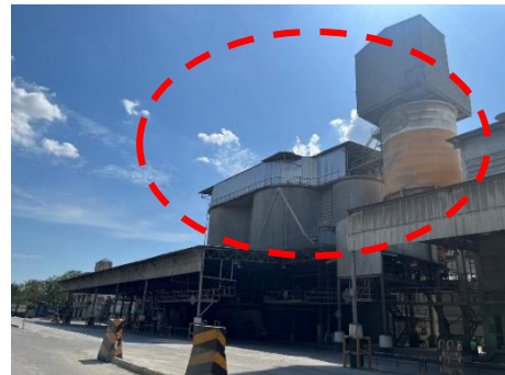
รูปที่ 58 ติดตั้งแผ่นเมทัลชีทบนไซโลปูนผง
