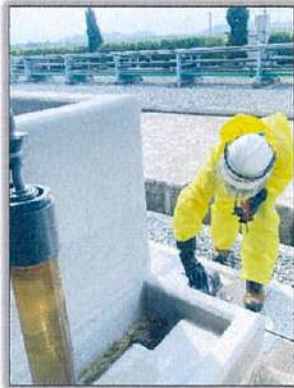
PO ใช้น้ำฉีดล้างทำความสะอาดรางระบายสารเคมี และเปิด Valve ระบายสารเคมีลง Neutralization Pit
