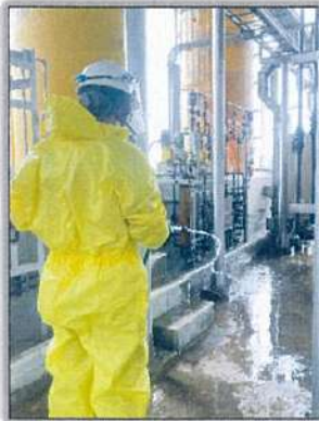
PO ใช้น้ำฉีดล้างทำความสะอาดรางระบายสารเคมี และเปิด Valve ระบายสารเคมีลง Neutralization Pit
