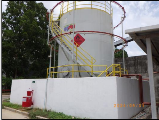
รูปที่ 2-16 คั่นคอนกรีตล้อมรอบลานถังน้ำมันดีเซล
