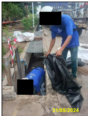
รูปที่ 2-20 การขุดลอกตะกอนรางระบายน้ำ
