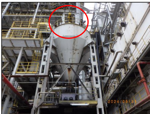
รูปที่ 2-57 การติดตั้ง Rapture Disk หรือ Safety Vent
