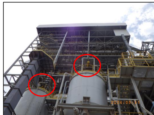
รูปที่ 2-57 การติดตั้ง Rapture Disk หรือ Safety Vent
