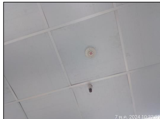
รูปที่ 2-49 อุปกรณ์ตรวจจับควัน
