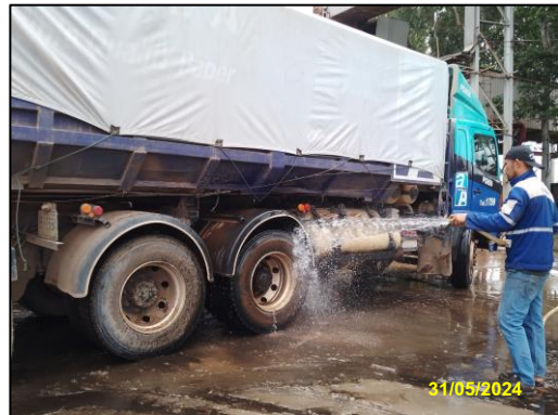
รูปที่ 2-27 การล้างล้อก่อนออกจากพื้นที่โครงการ
