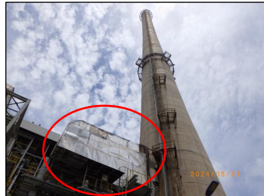
รูปที่ 2-3 ตำแหน่งที่ติดตั้งเครื่องตรวจวัดความเข้มข้นของมลพิษทางอากาศจากปล่องแบบอัตโนมัติอย่างต่อเนื่อง (CEMS)
