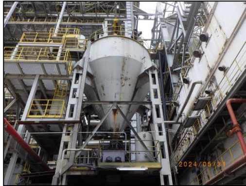
รูปที่ 2-34 ถังเก็บเถ้าหนัก (Bottom Ash Silo)
