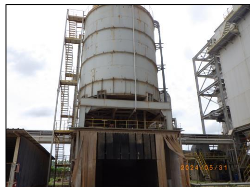
รูปที่ 2-33 ถังเก็บเถ้าลอย (Fly Ash Silo)
