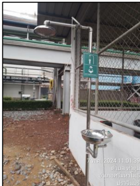
รูปที่ 2-46 อ่างล้างตาและฝักบัวชำระร่างกาย
