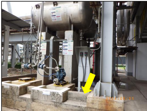
รูปที่ 2-44 เชื้อนป้องกันการรั่วไหลรอบถังบรรจุสารเคมี
