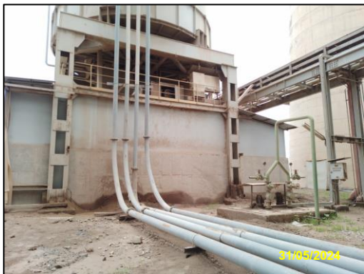
รูปที่ 2-9 ระบบลำเลียงเถ้าจากหน่วยการผลิตเข้าสู่ไซโล
