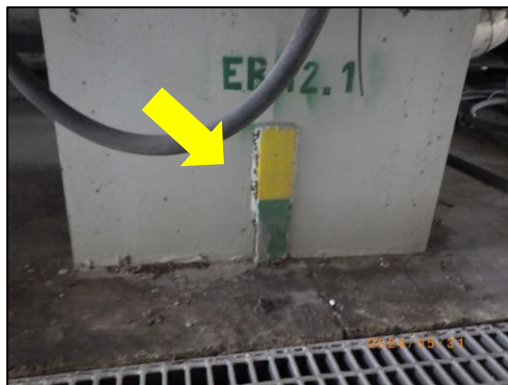
รูปที่ 2-55 สายดินบริเวณเตาเผาไหม้และปากไซโล
