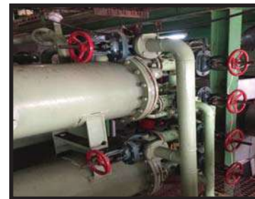
15. เปิดวาล์วระบายความร้อนของ น้ำมันหล่อลื่น
