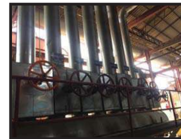
12. เปิดวาล์ว จากเฮดเดอร์แผ่นกัมหมัดไอน้ำ
