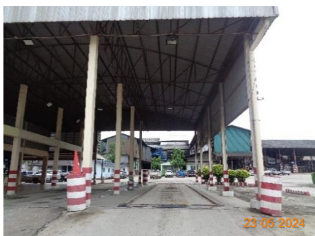
ภาพที่ 2.2-17 ทางขึ้นน้ำหนักรถบรรทุก
