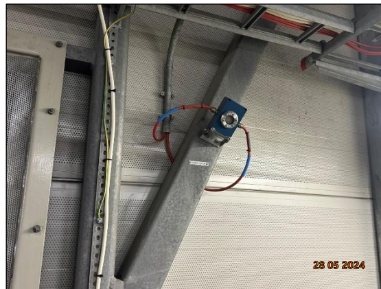
ระบบตรวจจับแสงและประกายไฟ
