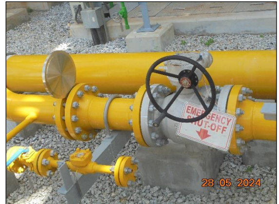
รูปที่ 2-32 อุปกรณ์วาล์วตัดแยกกระบวน (Manual Isolation Valve)
