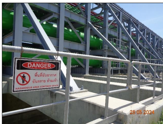
รูปที่ 2-9 บ่อพักน้ำทิ้งฉุกเฉิน (Emergency Pit)
