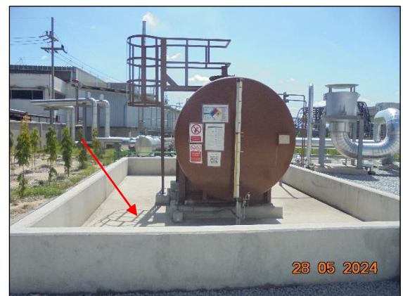
รูปที่ 2-36 คันกันป้องกันสารเคมีหกั่วไหล (Dike)
